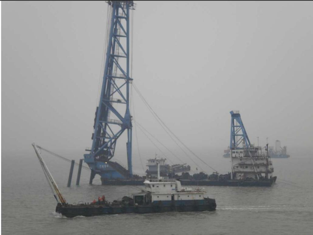
图 1-6 打桩船沉桩实作图
