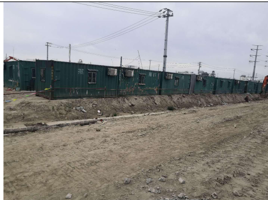
电缆管廊施工房
