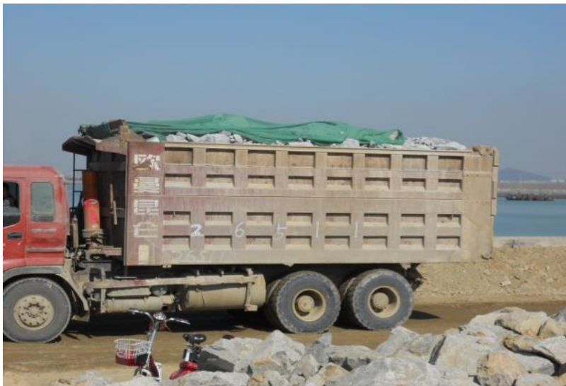
石料运输苫盖及洒水抑尘
