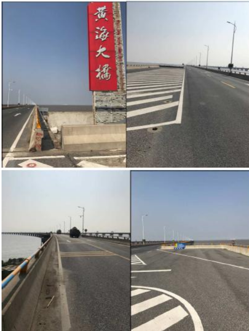
黄海大桥现状
