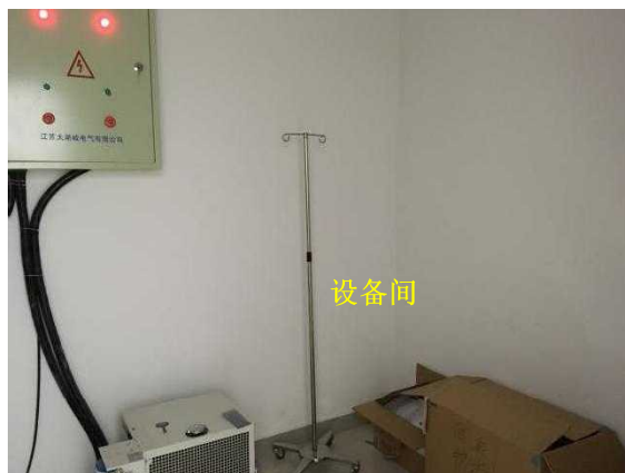
图 8-1 医技楼一层 DSA 机房（导管室）东侧
